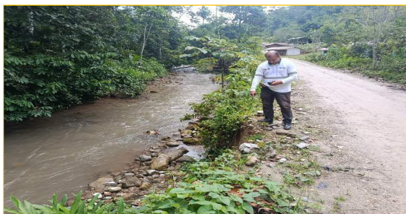
IMAGEN 02: EN LA MARGEN IZQUIERDA DEL RIO, SE PRESENTA EROSION LATERAL AFECTADNDO EL ANCHO DE LA VIA DE ACCESO.
